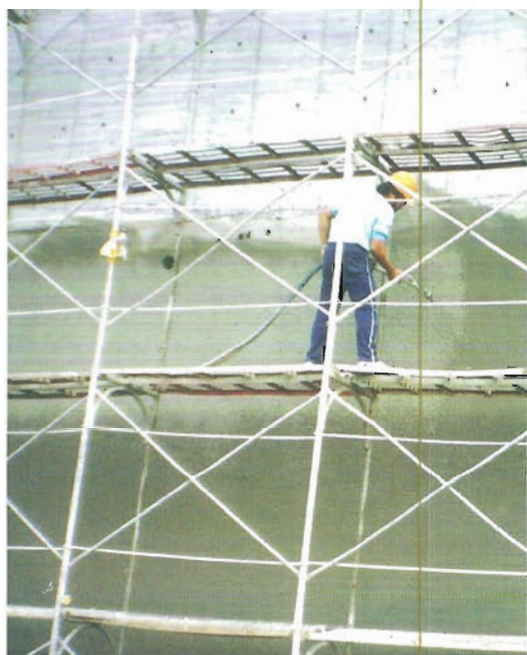
地下室外牆 防水彈力膠泥施工圖
