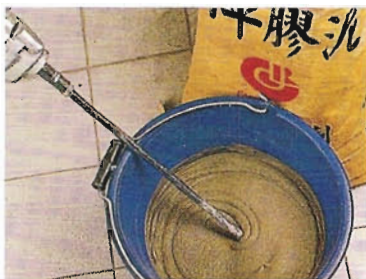
直接加水攪拌均勻使用
