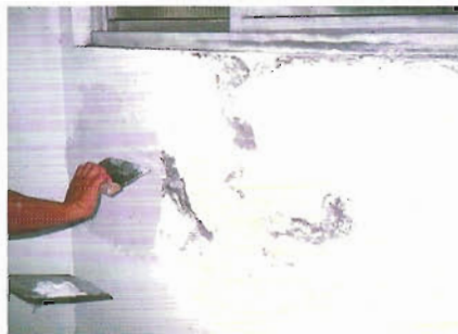
補寶施工之狀況
